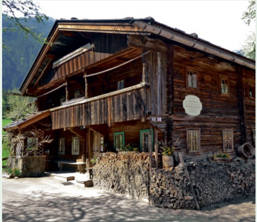
Das Wohnhaus der Familie Strasser in Laimach.
