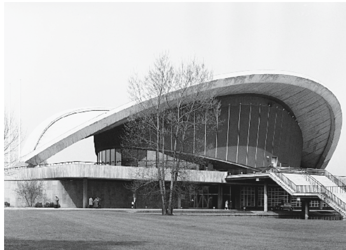
Kongresshalle, Berlin-Tiergarten, 1957, Architekt: Hugh Stubbins © Institut Heidersberger, Foto: Robert Häusser, Mannheim
